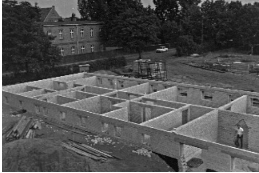
Bau der Kinderpsychiatrischen Rehabilitationsklinik, im Hintergrund das Paul-Gerhardt-Haus
